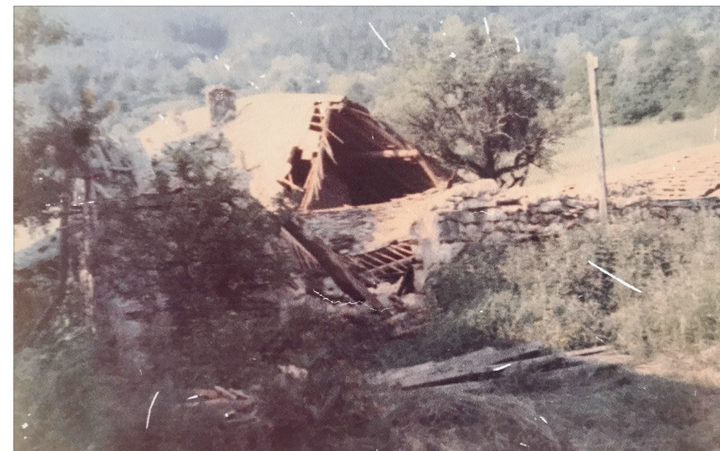
Fig 8 : Photographie en couleur prise depuis le chemin, pignon nord – 1975 – archives personnelles des propriétaires.
