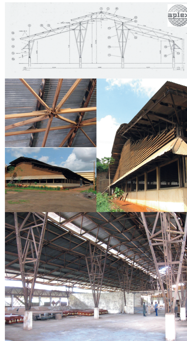
Fig.12 : le garage administratif de Yaoundé, construit en 1949-1950. Au-delà de la magistrale application de l'Aplex, le système de ventilation naturelle (ouverture basse grillées, tôle ondulée sur les pignons, lanterneau continu) est très remarquable et a (presque) parfaitement protégé le bois du pourrissement depuis plus de 70 ans. Coupe de l'ossature dans L'Architecture d'aujourd'hui , n°33, déc. 1950 – janv. 1951, p. XI ; logo Aplex ; © Gilles-Antoine Langlois, 11 mai 2017.
