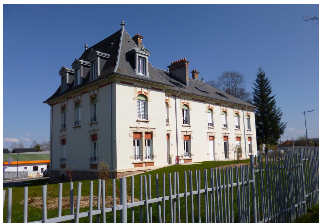
Figure 5 : la maison initialement destinée au médecin-chef et au gestionnaire. Etat après restauration récente. Photographie P. Labrude, 2019.
