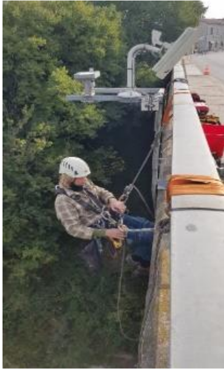
Figure 3: Potence articulée avec les capteurs : caméra, capteur radar de hauteur et depuis octobre 2021 un radar hauteur-vitesse
