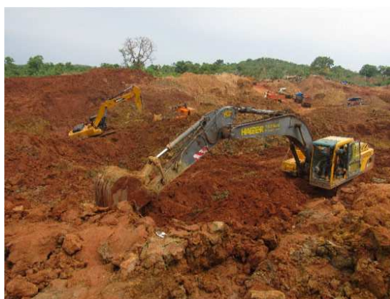
Extraction mécanisée de surface.
