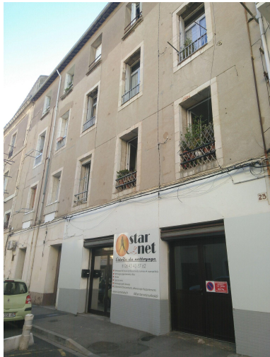
Immeuble en copropriété typique du centre ancien de Sète
