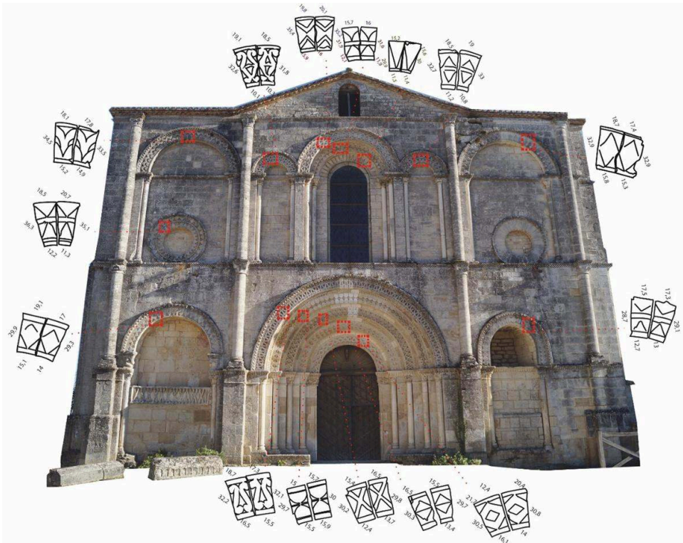
Fig. 15. Saint-Amant-de-Boixe (16), église abbatiale Saint-Amant, façade occidentale, détail du motif de claveaux (mesures en centimètres) (DAO, E. Chargé).
