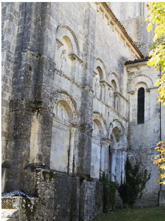
Fig. 7. Saint-Amant-de-Boixe (16), église abbatiale Saint-Amant, face occidentale du bras de transept nord et gouttereau nord de la travée orientale de la nef.
