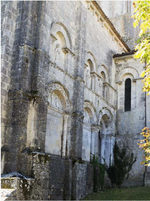
Fig. 7. Saint-Amant-de-Boixe (16), église abbatiale Saint-Amant, face occidentale du bras de transept nord et gouttereau nord de la travée orientale de la nef.
