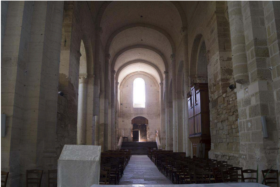
Fig. 13. Saint-Amant-de-Boixe (16), église abbatiale Saint-Amant, vue de la nef centrale depuis la croisée sous coupole.
