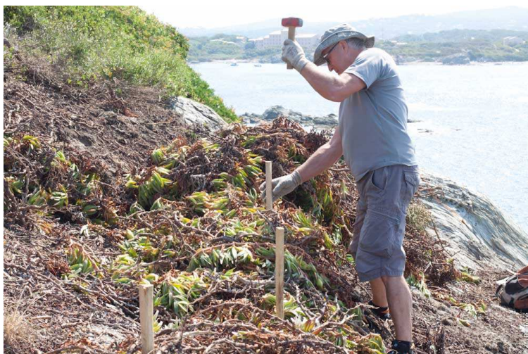
Figure 3 : Stabilisation d'un andain en piquets bois, dans un secteur à forte pente
