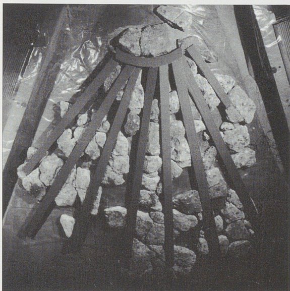
5. Ile Sainte-Marguerite, revers de la coupole, traces de l'armature en fer (matérialisée par des bandes de carton)
