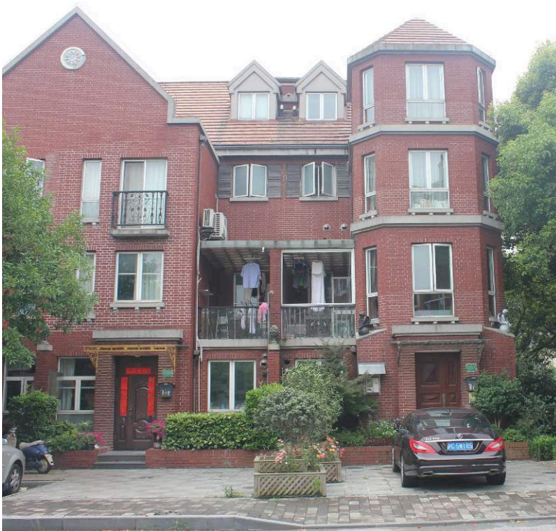
Figure 3. L'aménagement du balcon en buanderie
