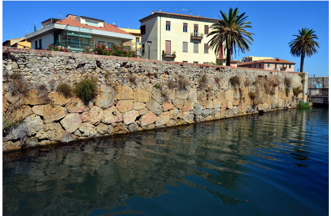
Muraille étrusque ceinturant la ville d'Orbetello, 3e siècle av. J.-C.
