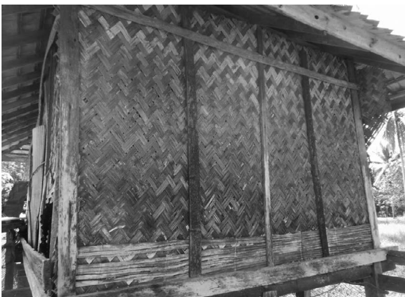
Fig. 78. Détail de la cloison de bambous fendus et tissés d'un grenier à riz (photo Pierre Le Roux, Pattani, 1992).
