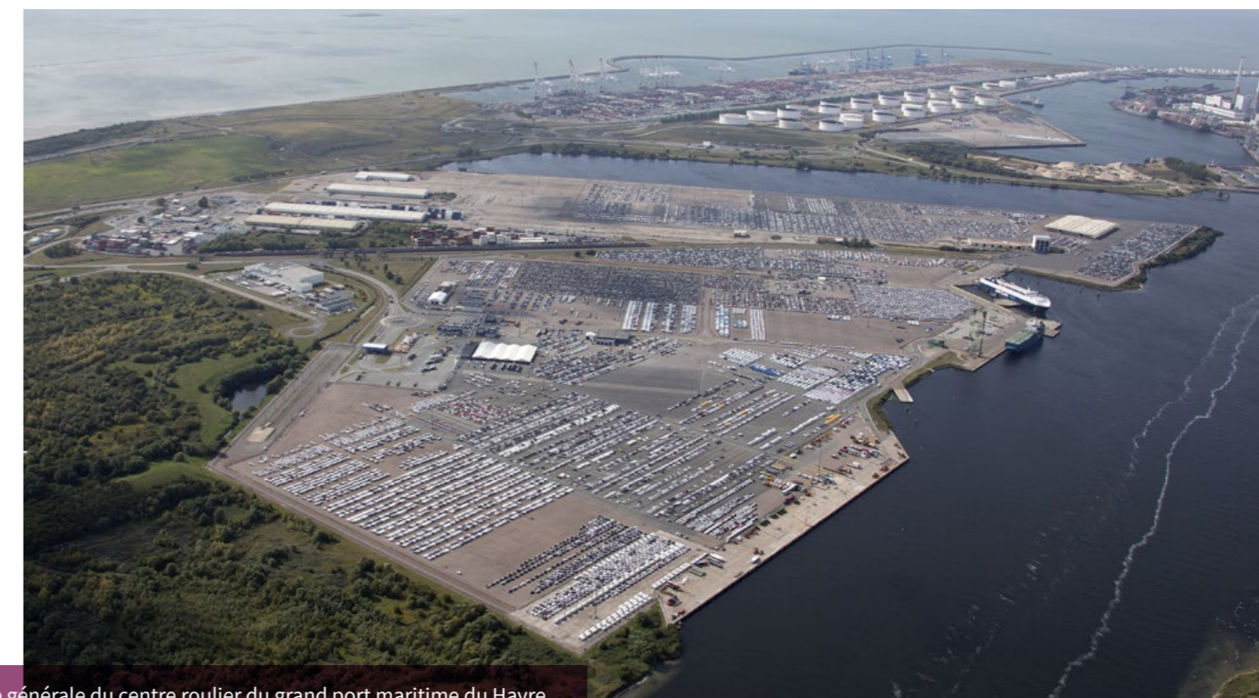
Vue générale du centre roulier du grand port maritime du Havre. © Michel BIZIEN – Grand Port Maritime du Havre
