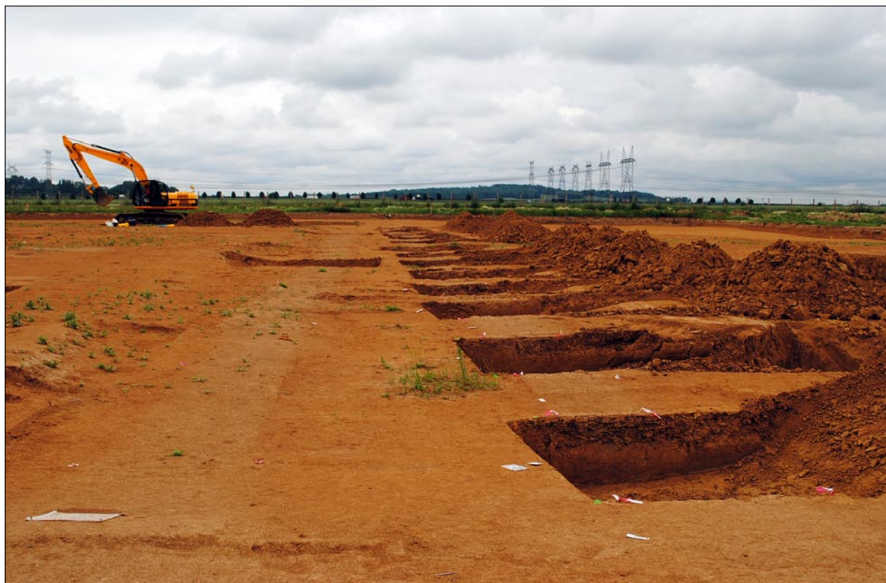
Fig. 92 – Cliché depuis le sud-est des fossés 002 (à droite) et 004 (à gauche) en cours de sondage
