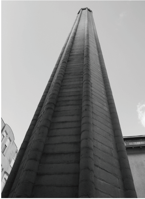
Fig. 7. Chimenea conservada en las inmediaciones de la biblioteca. Fuente: Elaboración propia, enero de 2016.
