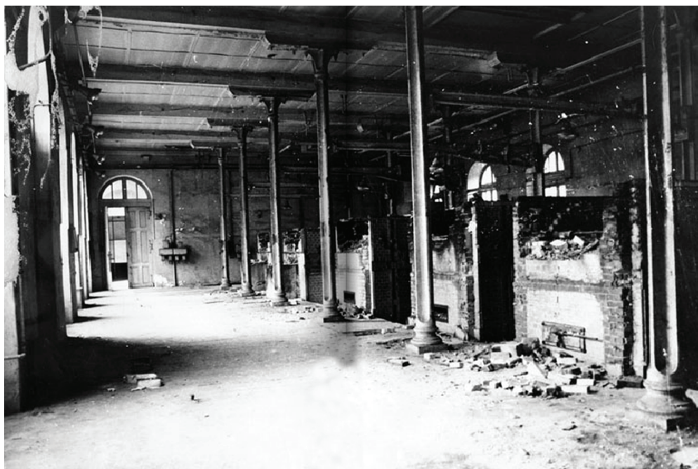
Fig. 5. Hornos de torrefacción antes de su rehabilitación entre 1981-83. Fuente: Archives municipales de Nantes .
