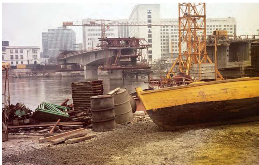
Figure 8 – Le pont Haudaudine en construction (© Archives de Nantes, fonds Gilbert Champenois, photographe, 147Z287)
