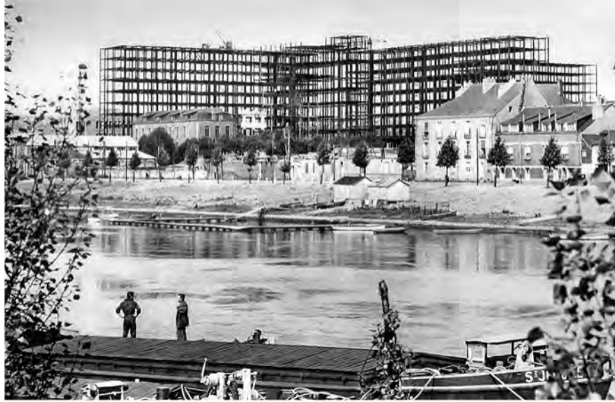
Figure 9 – ROUX-SPITZ, Michel, Réalisations , vol. III, 1943-1957, Paris, éditions Vincent, Fréal et C ie , 1959, pl. 42. « Centre hospitalier régional de Nantes. Montage de l'ossature métallique. Ensemble sud-est vu de la Loire » (© coll. particulière)
