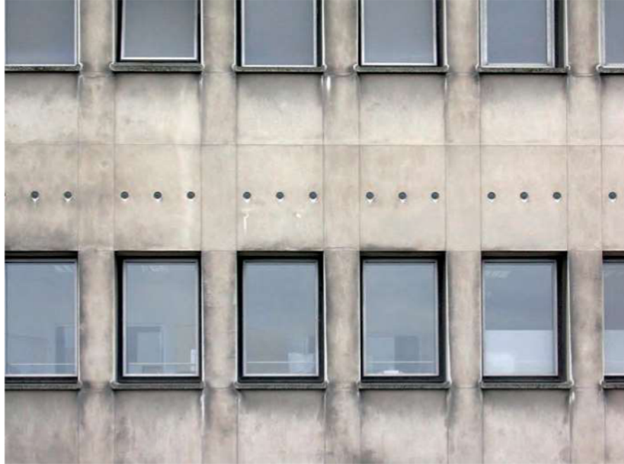
Figure 13 – Aile ouest, façade nord, baies étroites et oculi d'une galerie technique, mai 2005 (© cl. G. Bienvenu)
