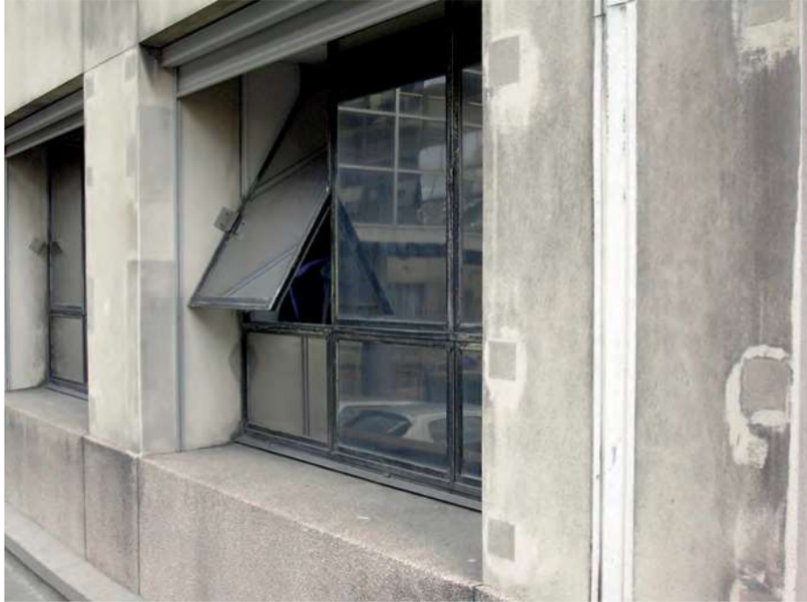
Figure 15 – Aile est, baies du soubassement, mai 2005 (© cl. G. Bienvenu)
