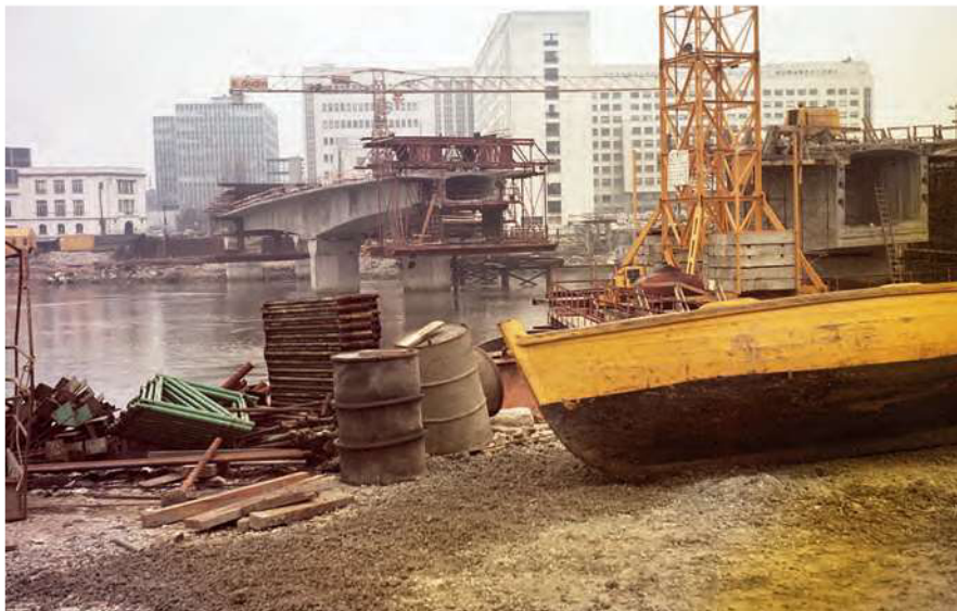
Figure 8 – Le pont Haudaudine en construction
