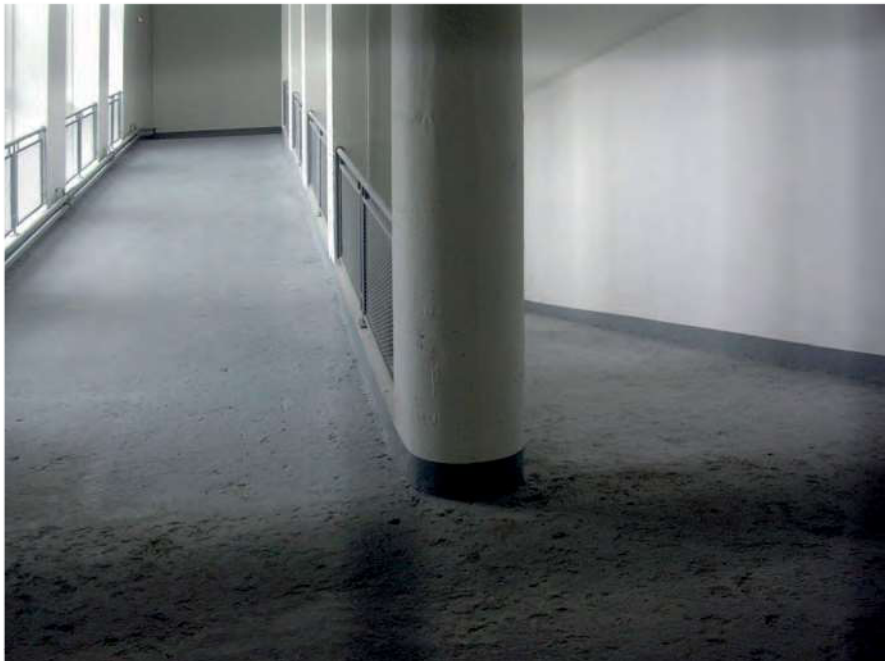
Figure 16 – Une rampe d'évacuation désaffectée, mai 2005 (© cl. G. Bienvenu)
