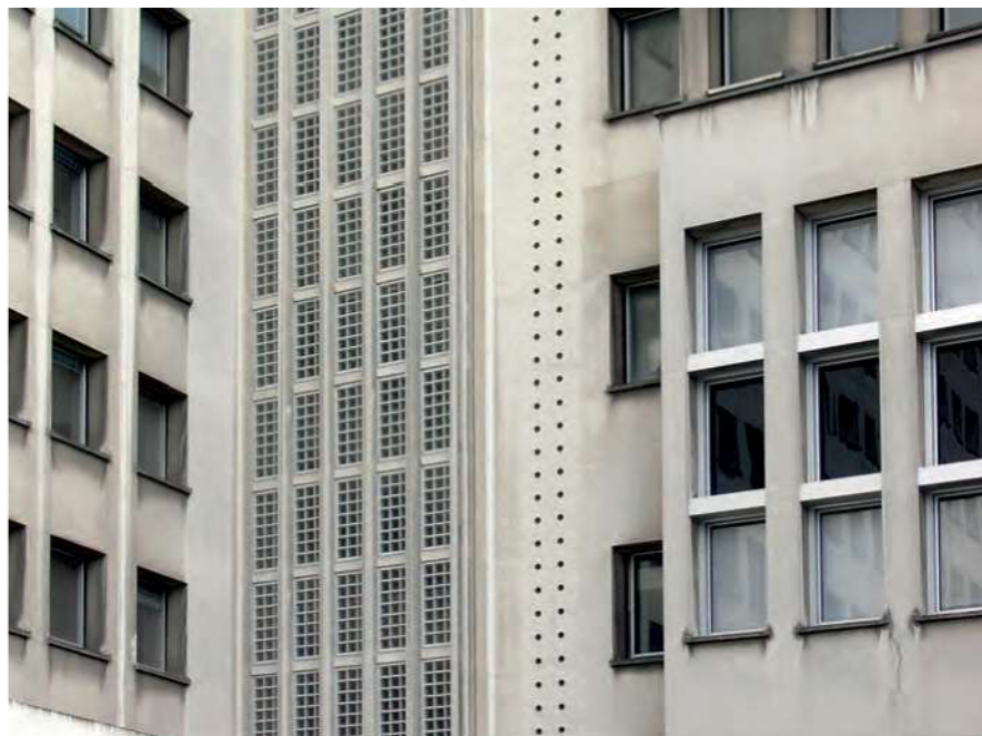
Figure 12 – Traitement différencié des façades à l’angle de la façade nord, mai 2005 (© cl. G. Bienvenu)
