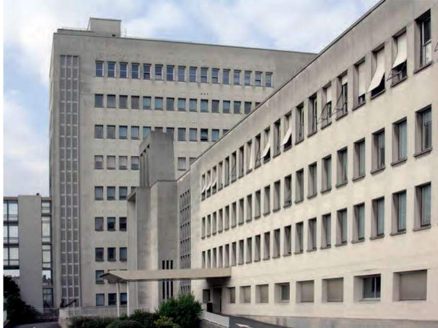
Figure 17 – Le « clocher-porche » de la chapelle, entre l'aile est et le bâtiment de l'administration, mai 2005 (© cl. G. Bienvenu)
