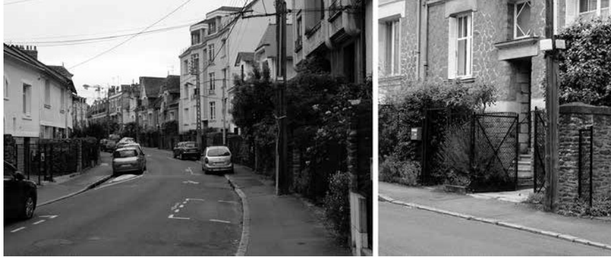
Figure 16 – Le lotissement communal de la rue Anatole-Le-Braz
