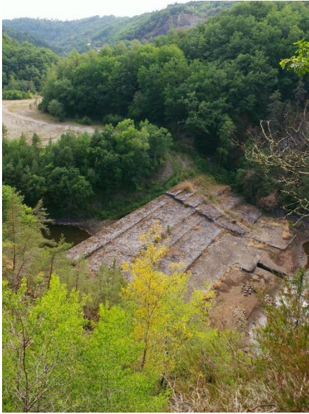
Figure 4. Le barrage vu du versant rive gauche. Août 2022. © V. Thiéry.
