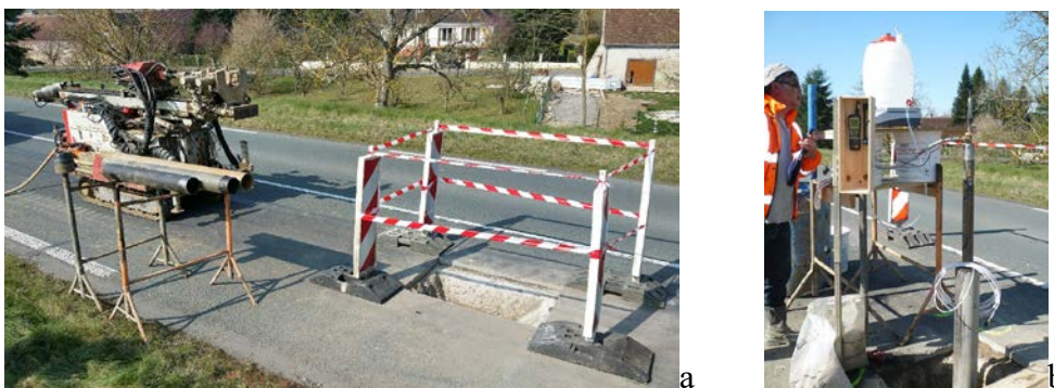
FIGURE 2. Essais pour comparaison dans l'écran a) et dans le corps de digue b) (DREAL Centre-Val de Loire).
