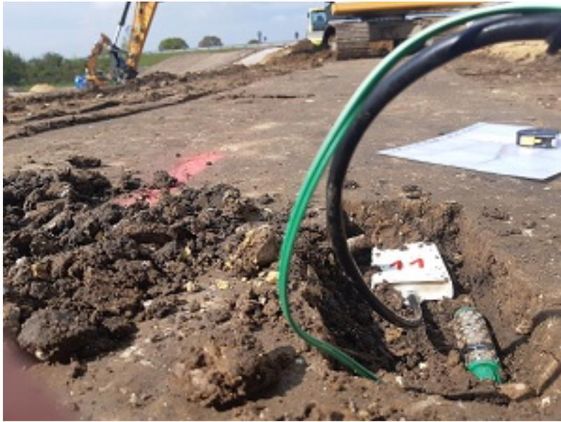
FIGURE 3. Pose d'une sonde TDR (blanche) et d'une sonde de succion (verte) à La Riche.
