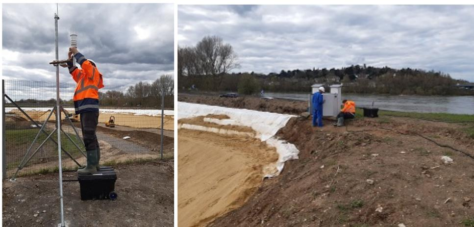
FIGURE 4. Installation de la station météorologique et de l'armoire hébergeant la centrale d'acquisition.
