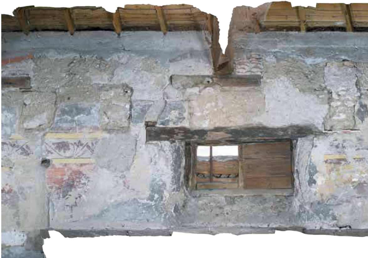
Figure 9 : Détail de l'UM4, orthophotographie
