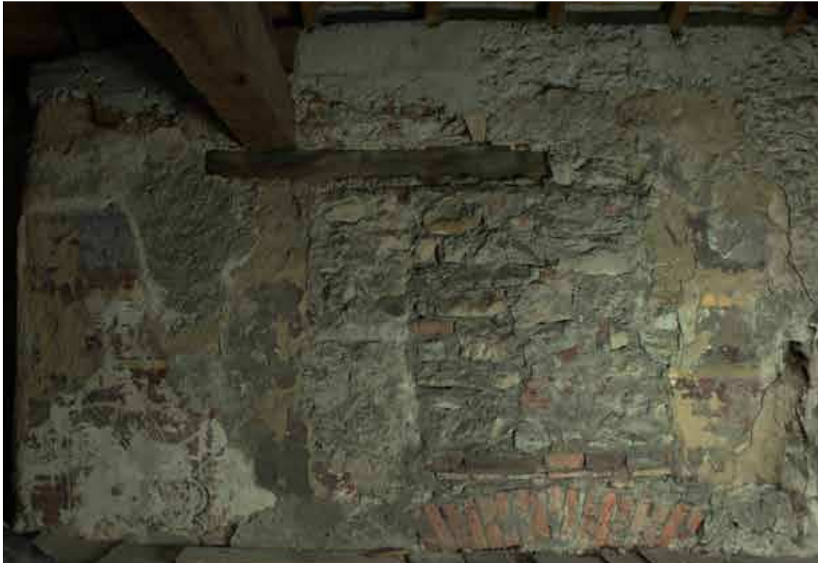
Figure 8 : Détail de l'UM1, orthophotographie
