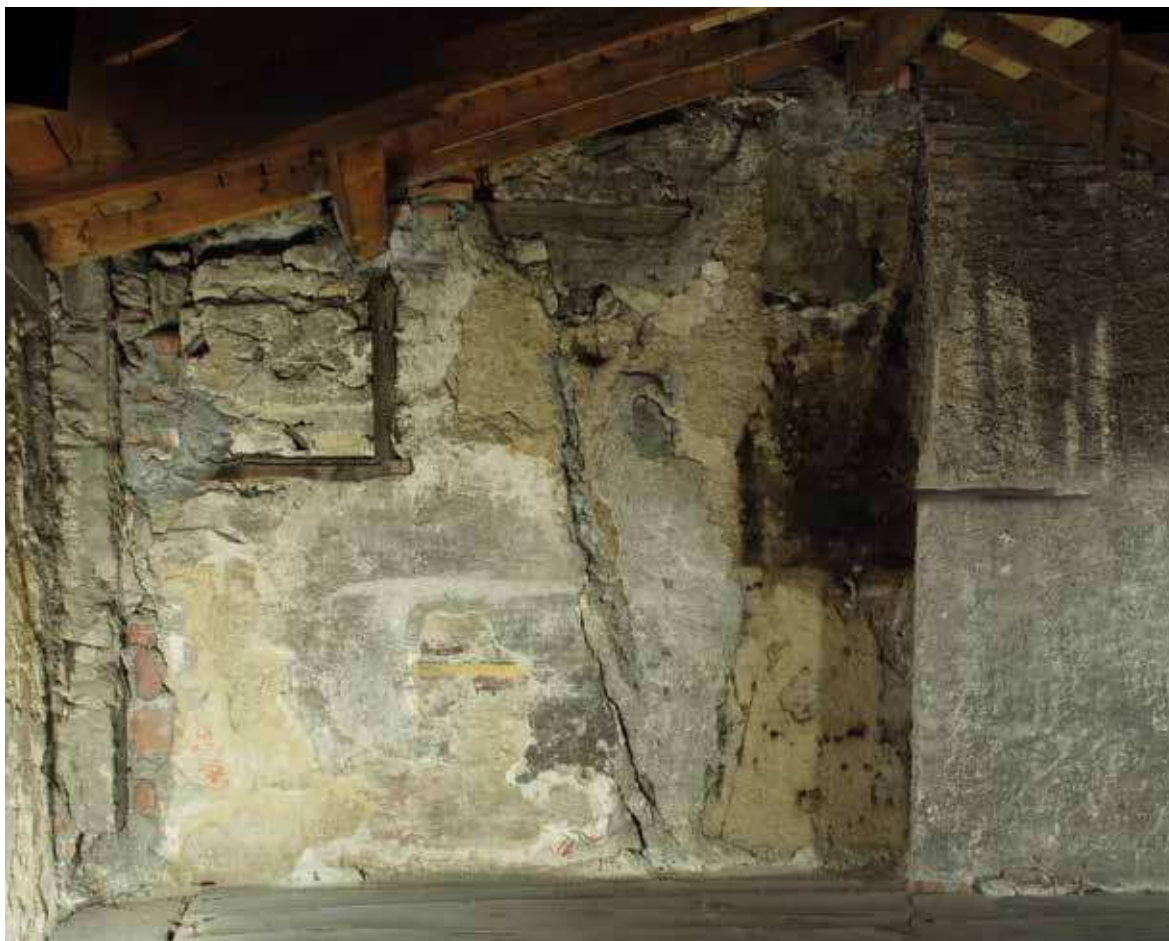
Figure 10 : Détail de l'UM3, orthophotographie
