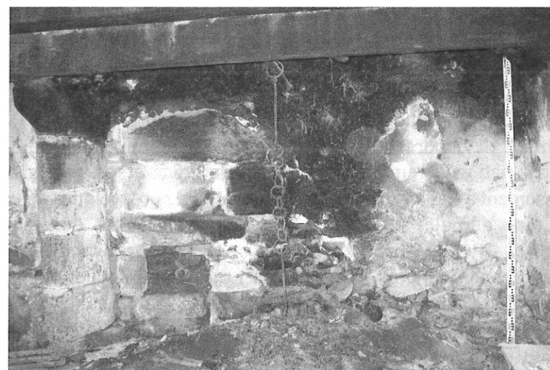
Cheminée C15 et son four à pain, RDC
