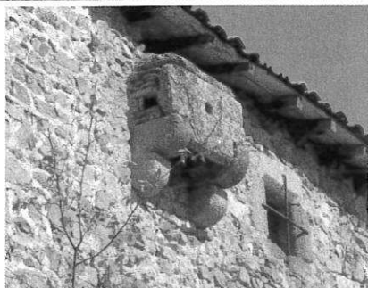
Bretèche B13 et baie B14, combles
