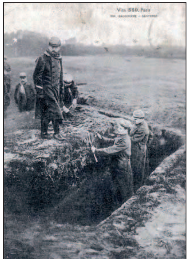
Fig. 63 : Creusement d'une tranchée en 1914 (source : site internet du 63e Régiment d'Infanterie)
