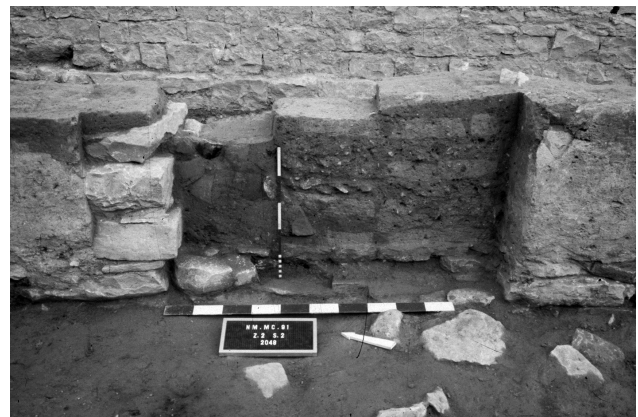
Fig. 7 – Vue de détail de la cloison d'adobe MR2048 qui condamne la porte dans l'axe du mur MR2034 (Cl. M. Célié).
