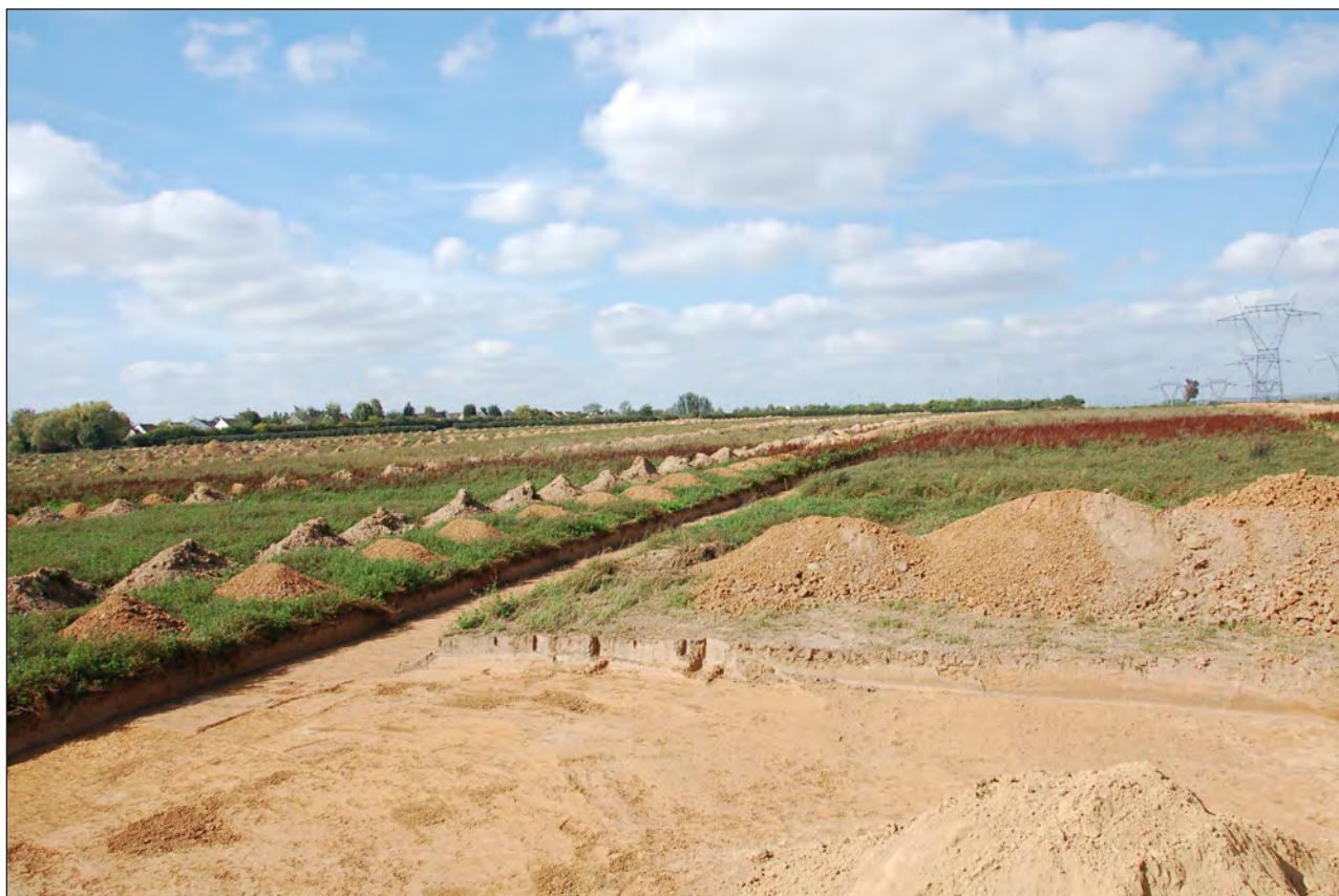
Fig. 5 : Vue du secteur A en cours de décapage (Cliché : J.-G. Pariat).
