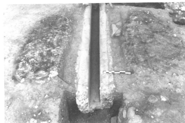
Fig. 14 : vue de l'aqueduc haut, non loin de son point d'arrivée. Les deux lentilles présentes de part et d'autre du canal correspondent aux traces laissées par le chantier de construction (restes de chaux, béton de tuileau) et recouvrent le sol cultivé augustéen (cliché S. MAUNÉ, 1999).
