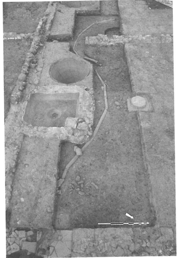
Figure 40 - Canalisation sous pression constituée de tuyaux moulés provenant de l'atelier de Dourbie (Aspiran, Hérault) installés dans les remblais de la villa de Saint-Bézard (cliché S. Mauné).
