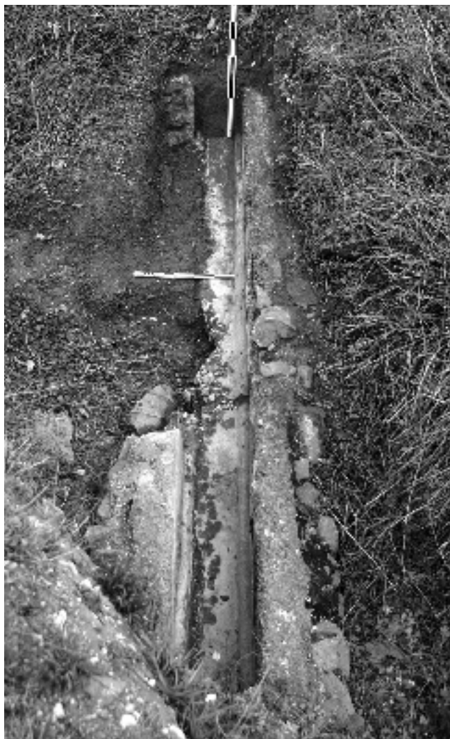
Fig. 5. Vue du tronçon d'aqueduc visible dans un fossé de la route de Caux. Cl. S. Mauné
