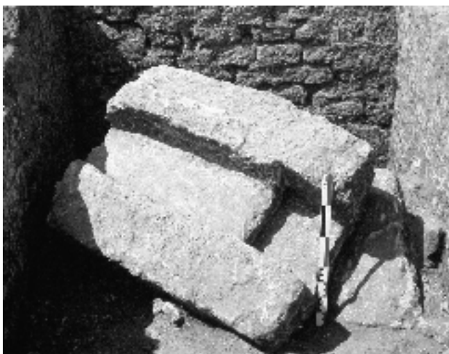
Fig. 9. Vue prise du bloc/canal terminal, en grand appareil, de l'aqueduc, effondré dans le coursier du moulin. Cl. S. Mauné
