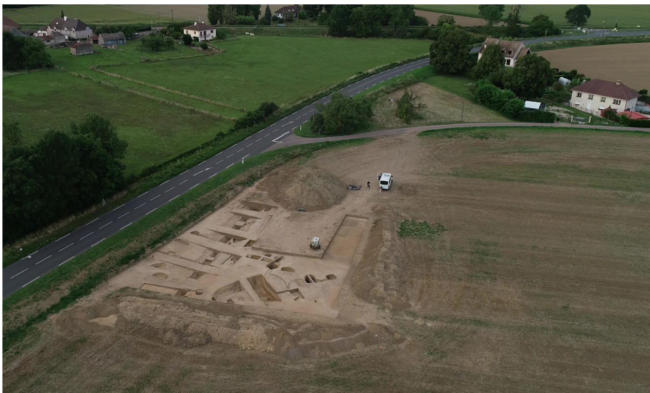
Fig.19 Vue de fin de chantier aéroportée par drone, en direction du nord-ouest (E. Hamon)
