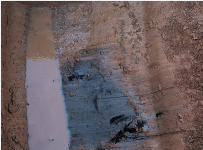
Fig.178 Niveau d'apparition du cuvelage en chêne du puits [3023] (cliché E. Hamon)
