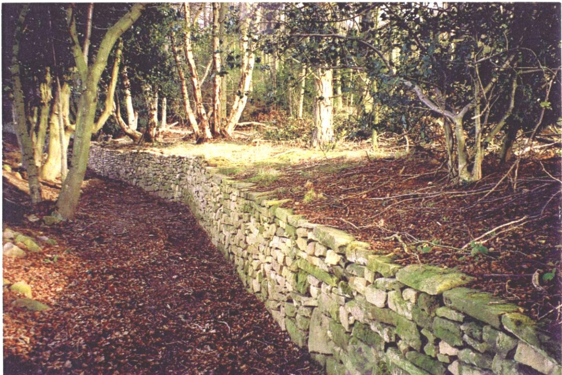
Fig.7 – Restauration du Ha-ha (Angleterre)
