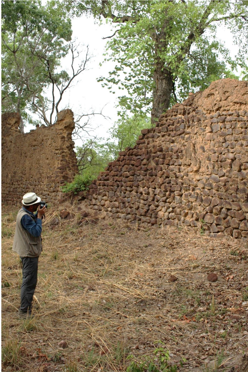
Fig.6 - Photographie d'un pan de mur en vue de la modélisation 3D d'une partie de l'enceinte Photo R. Guillon, 2015
