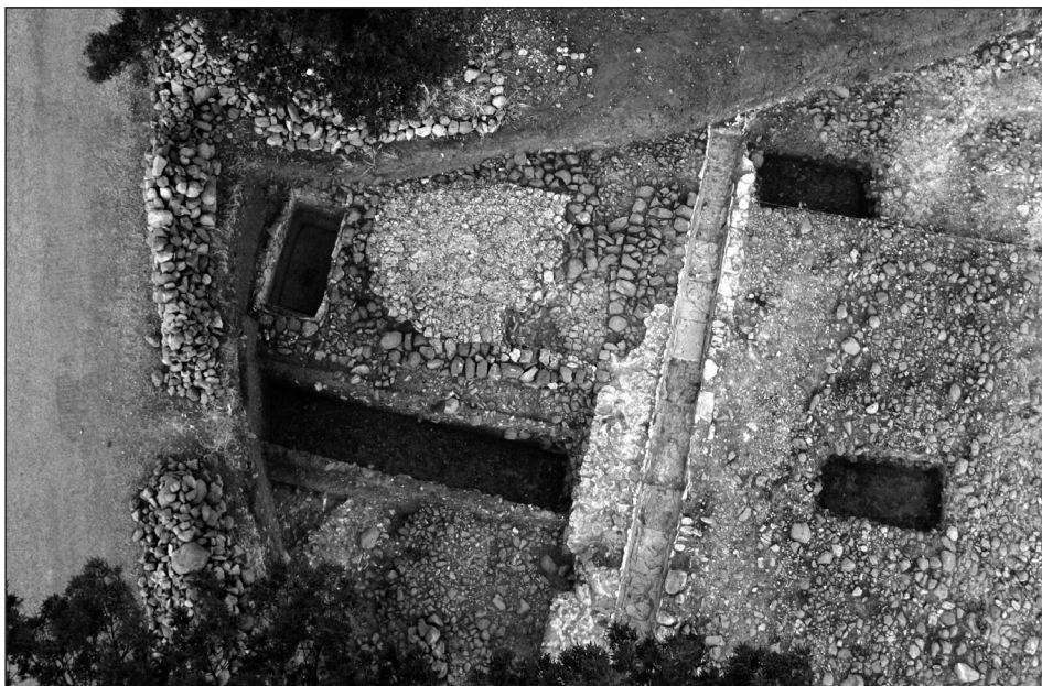
Fig. 9 : Vue générale du fouloir et de la cuve de réception du jus tardo-antiques installés contre l'aqueduc de la natatio . Photo S. Mauné 2009.
