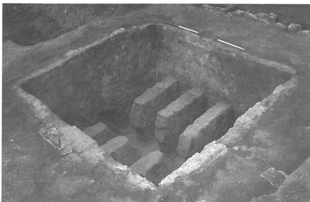
Figure 8 - Vue de la chambre de chauffe et de la partie conservée du laboratoire du four 1004 de l'atelier de Bastide-Neuve (cl. Ch. Newman).
