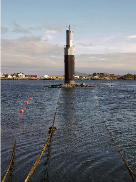
Le prototype de centrale marémotrice flottante « Morild », photographié dans le port de Svolvær en juin 2014
