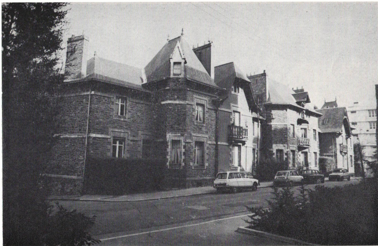
Alignement 22 au 30, rue du Préfet Bonnefoy architecte : F. Bougouin - vers 1895
