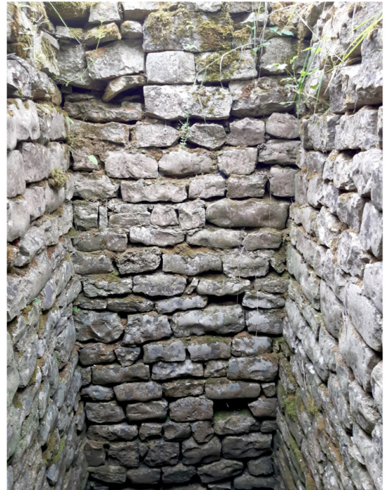
Figure 9 : parement de l'intérieur de la structure F3. Noter l'usure des pierres (Cl E. Yény).
