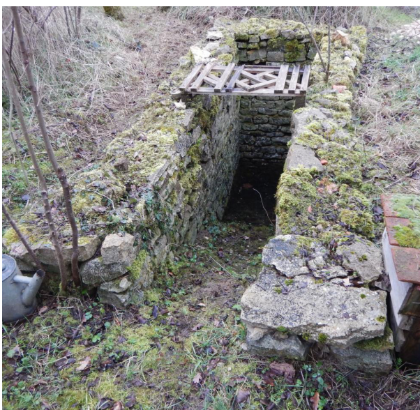
Fig. 10. F3 le 28 janvier 2021. Là encore de l'eau apparaît au fond, qui aura disparu en août. Cl. E. Yény.
