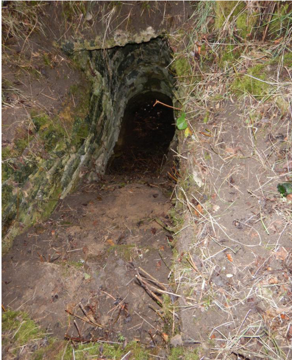
Fig. 8. F1 le 28 janvier 2021. Noter l'eau présente au fond, qui aura disparu lors de l'opération d'août. Cl. E. Yény.
