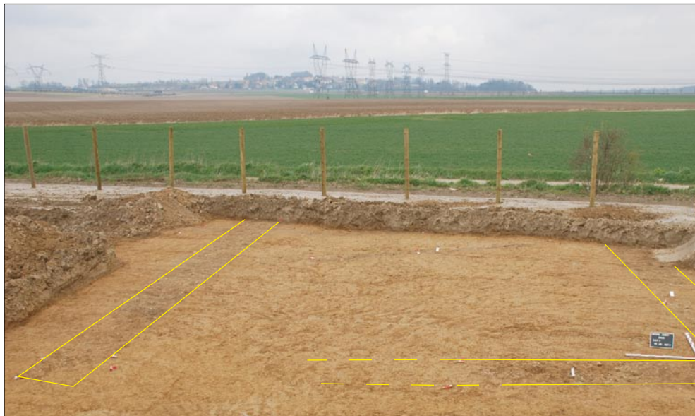
Fig. 37 : Bâtiment 2, Tranchée 0a.
