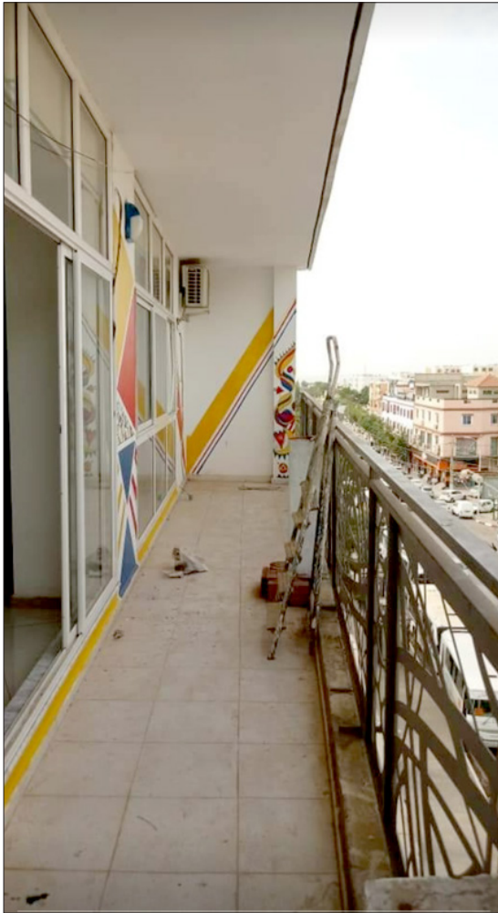
Figure 6. Façade de l'école , Blida, 2019. © Gaëlle Hemeury.
