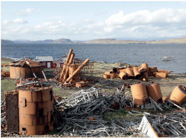
[Fig. 2]: Vue des vestiges de l'usine de Port Jeanne d'Arc (photo J. Vidal)
