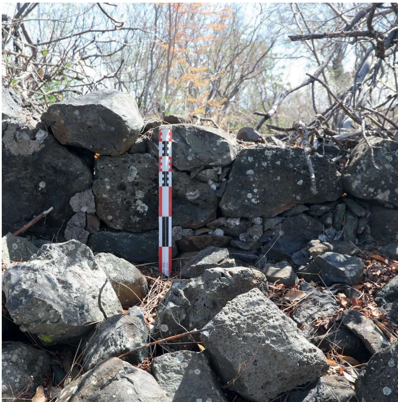
[Fig. 7] : Les murs maçonnés du secteur 1 (photo J. Vidal / SRA de La Réunion)
