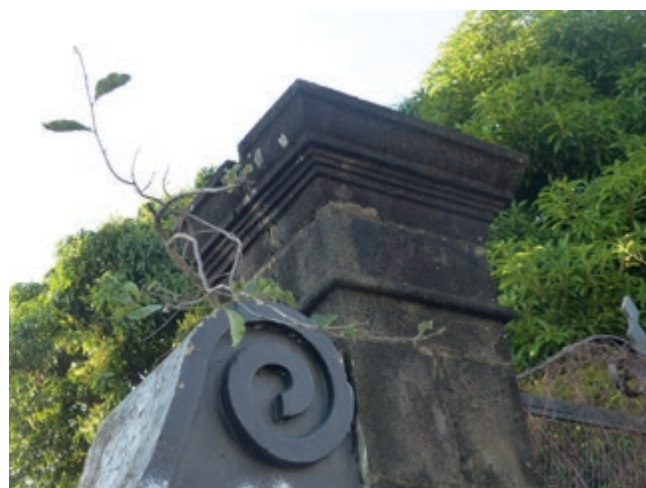
[Fig. 2]: Détail du pilastre nord et d'une volute (photo T. Cornec / Inrap)
