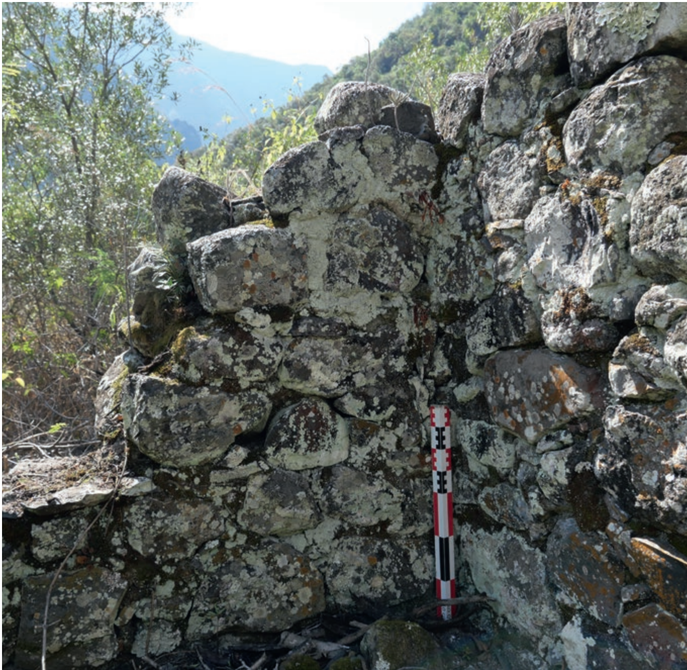
[Fig. 6] : Vestiges encore en élévation du hameau de la Roche ancrée (photo F. Lachery / Inrap)
