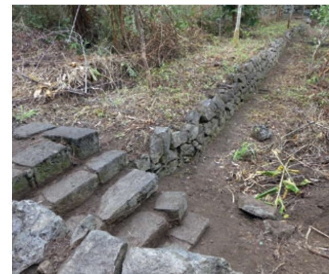
[Fig. 8]: Escalier entre les terrasses (photo T. Cornec / Inrap)
