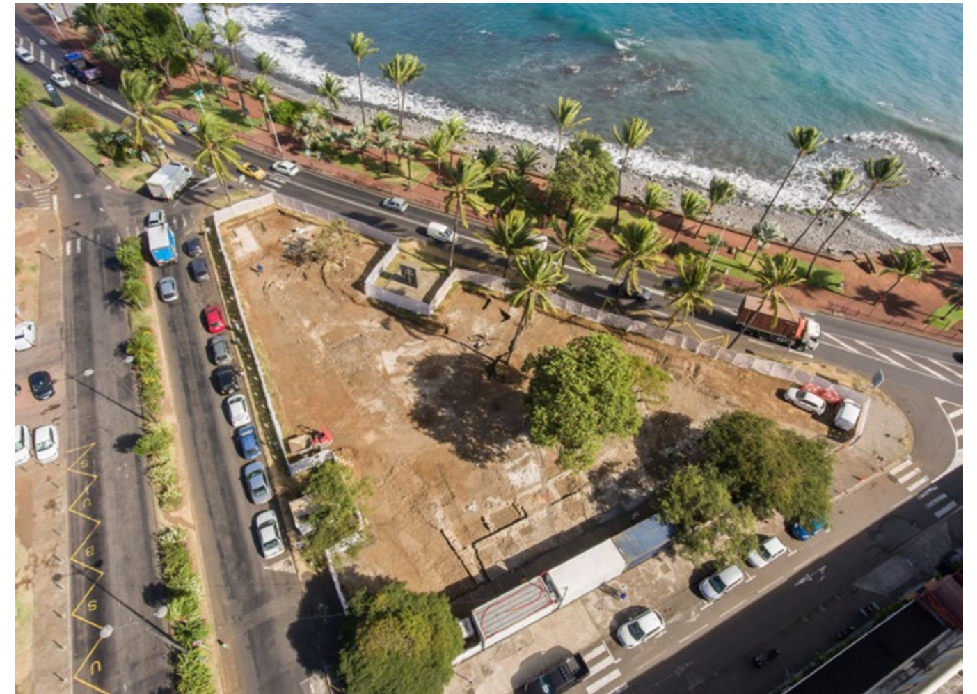
[Fig. 9]: Vue aérienne du chantier en cours de fouille (photo A. Vaccaro / Agence Wopé!)
