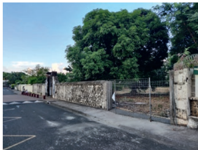
[Fig. 1]: Aspect de la clôture maçonnée sur la rue de la Caserne (photo T. Cornec / Inrap)
