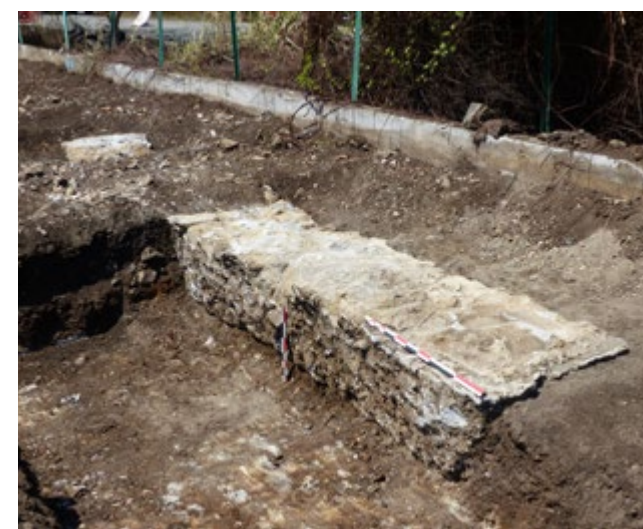
[Fig. 4]: Vue générale de la fondation du mur du sondage 8 (photo T. Cornec / Inrap)
