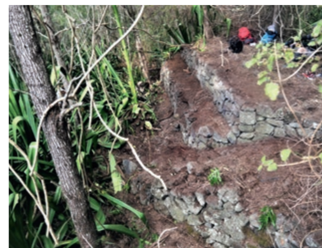
[Fig. 4] : Le mur de terrasse étagé de l'habitat proche du plateau Picard (photo F. Lachery / Inrap)
