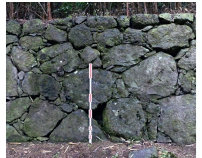
[Fig. 6]: Détail de l'appareil du mur 1204 en pierres sèches (photo T. Cornec / Inrap)
