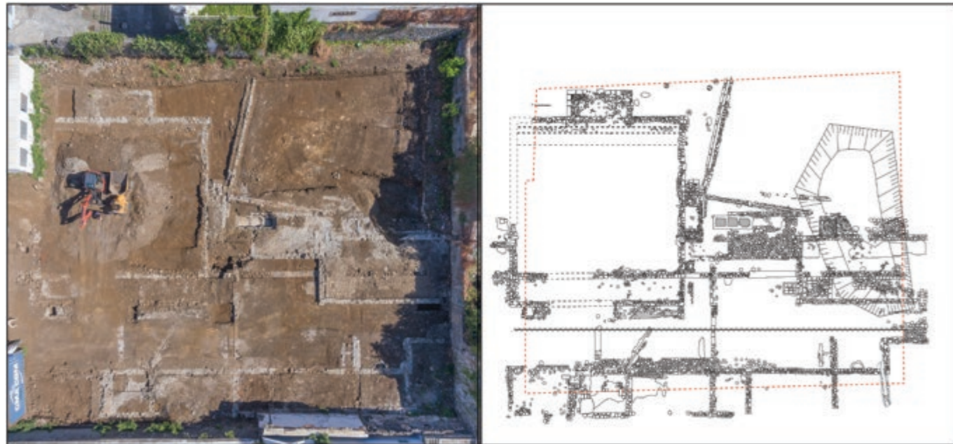
[Fig. 3] : Relevé de l'ensemble des structures et vue aérienne du chantier (photo A. Vaccaro / agence Wopé !, DAO W. Migeon / Inrap)
