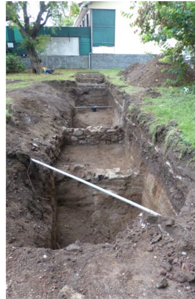
[Fig. 2] : Vestiges de bâtiment et succession de remblais d'exhaussement et de sols de circulation, sondage 100 (photo W. Migeon / Inrap)
