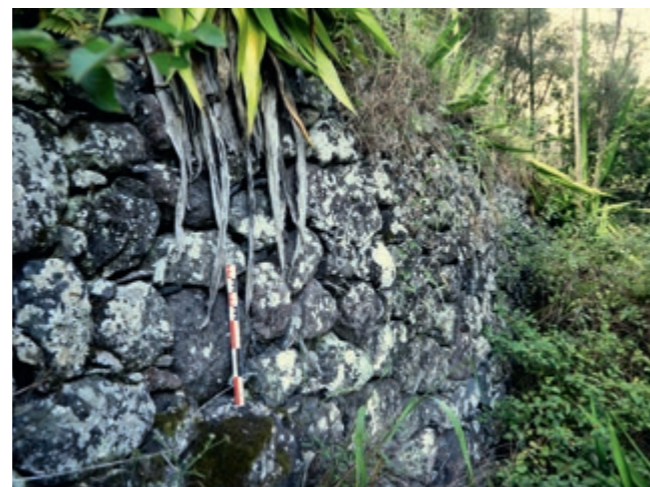
[Fig. 8] : Mur de terrasse de la maison Bidel (photo J. Vidal / SRA de La Réunion)
