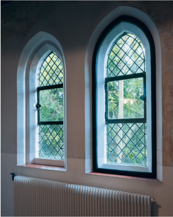
4. Roubaix, ehem. Klarissenkloster, Fenster mit und ohne zweite Scheibe, 2021
