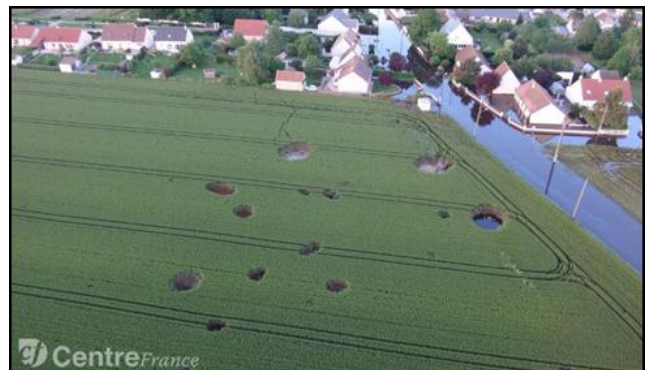
Effondrements d'une carrière souterraine à Gidy
