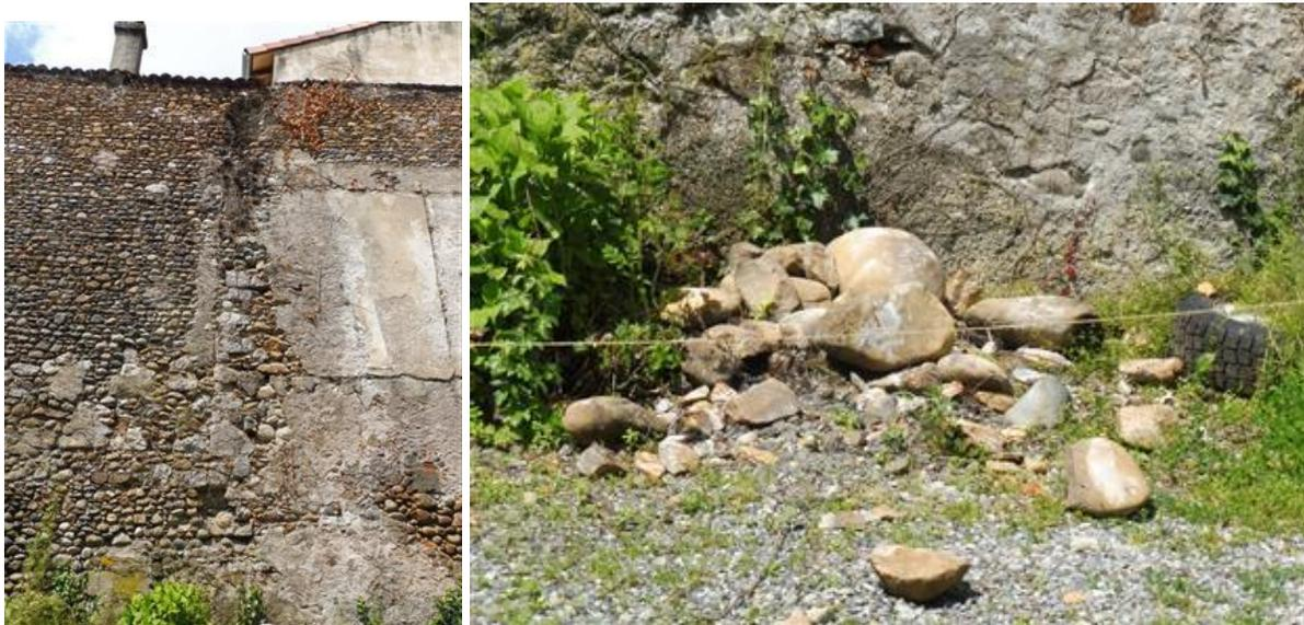
Figure 2. 22 – Chutes d'éléments de maçonnerie sur un mur de propriété (photos M.P. Arrieu 2023)
