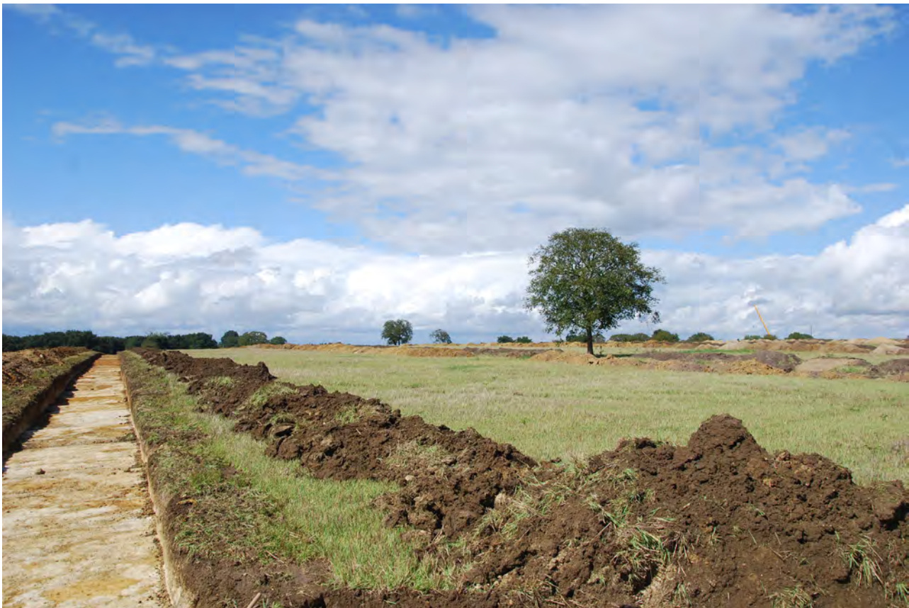
Fig. 81 : Vue panoramique du secteur diagnostiqué.
